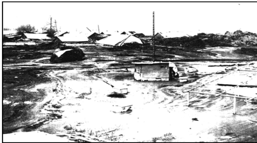
Рис.2. Вид поселка после оползней в результате землетрясения 22 января 1989 г. на Гиссарском хребте
